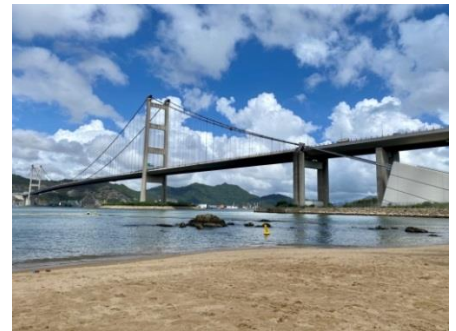
在馬灣東灣泳灘近距離觀賞青馬大橋及汀九橋的景色，享受一下慢活生活。 Tung Wan Beach is a good location to admire the beauty of Tsing Ma Bridge.
